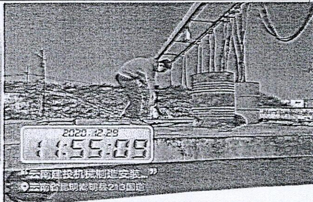
探伤机房楼顶检测
