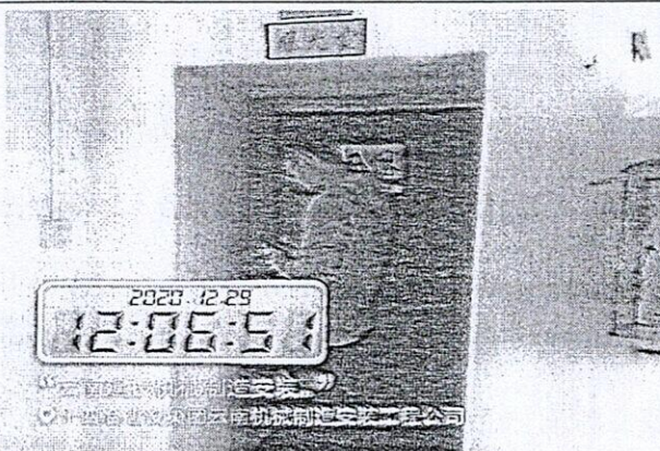
探伤机房铅门检测
